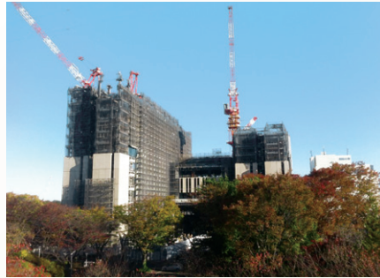
2013年5月完成に向け、建設工事が進む新総合教育棟
