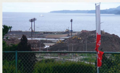
◀積み上げられた瓦礫(岩手県大船渡市)
