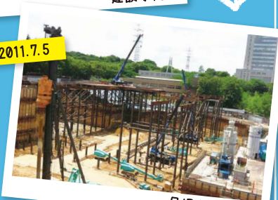
足場が組まれた
